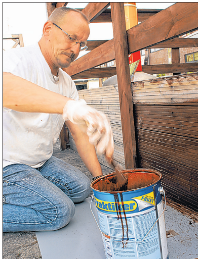
Hans-Jürgen Zuther (55) streicht die Terrasse des Indoor-Spielplatzes. Seine Arbeitsstelle ist wie ein zweites Zuhause, meint er.
